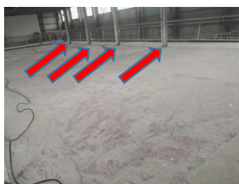
图 4 二层清空后地面和立柱情况
